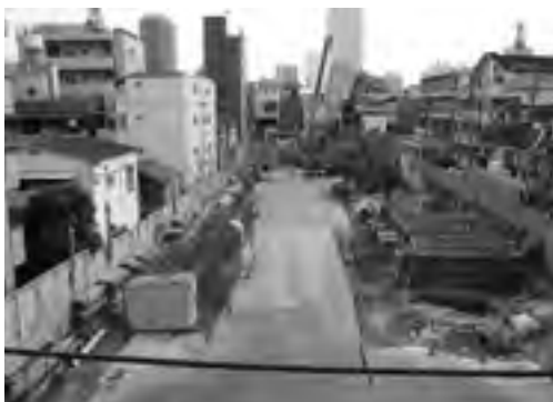
巣鴨4丁目の建設現場
