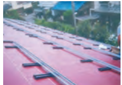
支持金物取付後
