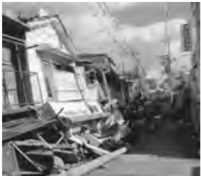
1階が倒壊した2階建ての店舗併用住宅。間口が広く壁が入っていないために倒壊した典型例
