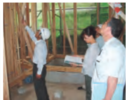
生協社内現場検査
