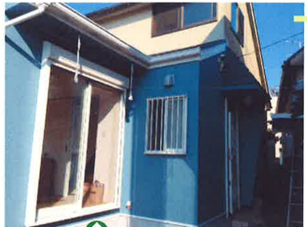
リフォーム後の外観です。
