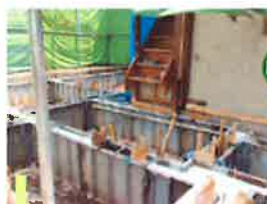
既存の家を一部取り壊しての改築です。
