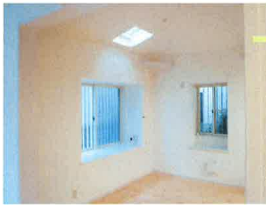
トップライトを新設し明るい居室に変わりました。
