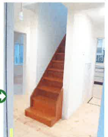
階段は古いまま、床や壁は新規建物です。
